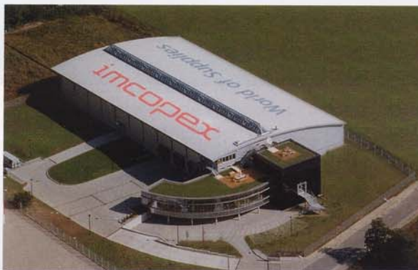
◀ Auf 2500 Quadratmetern sämtliche Kernmarken vorrätig: Luftaufnahme des Logistikzentrums in Hamburg
