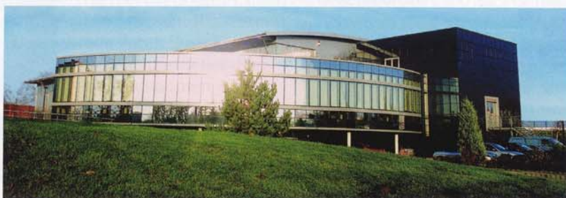
▼ Das Firmengebäude: Empfang und Verwaltung sind der Logistik vorgelagert.
